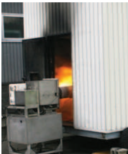
写真 No. 26 熱源装置側 （バーナー作動状況）
