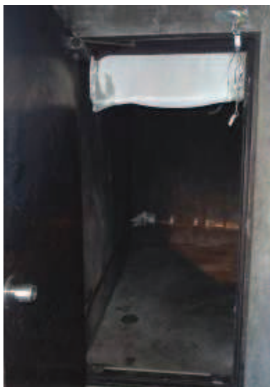
写真 No. 15 開口部高さ:1.5m
