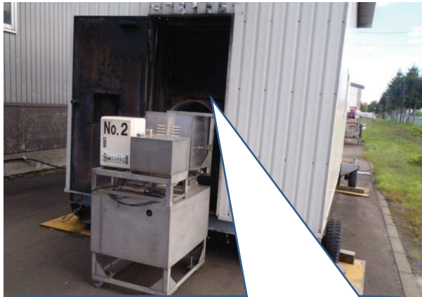
出入口を穴あき鋼板で覆いバーナー部を挿入
