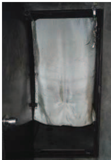
写真 No. 17 開口部高さ:0.5m
