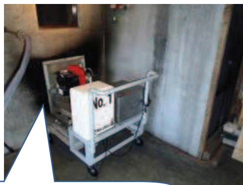
壁面に穴を開けバーナー部を貫通
