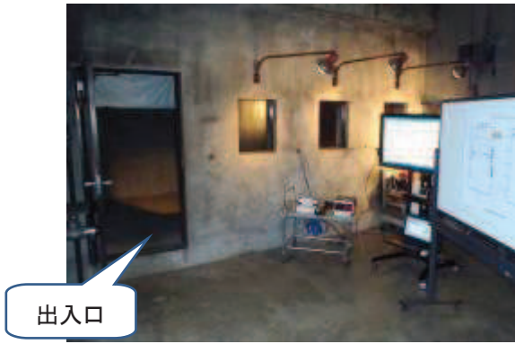
写真 No. 1 訓練塔訓練室 (前室から外観を撮影)
