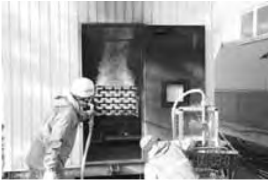
写真5 消火水の放射開始状況
