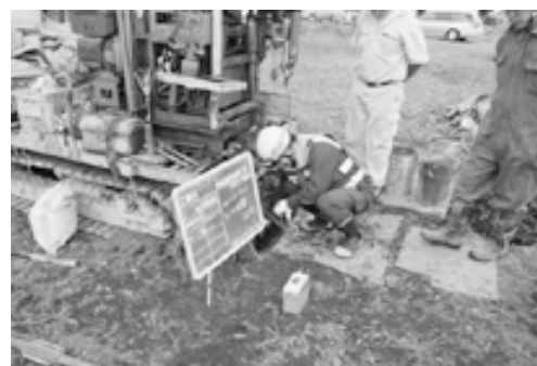
写真4 ガス検知の状況
