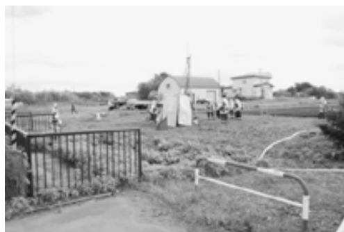
写真1 現場周囲の状況
