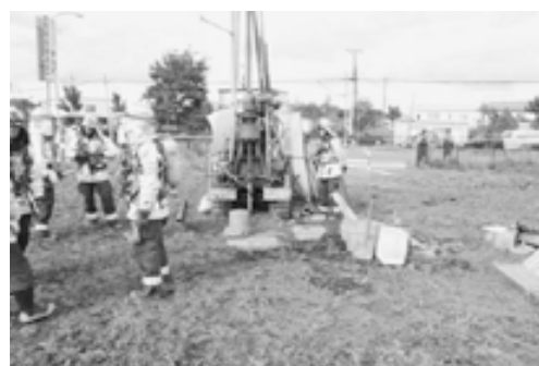
写真2 ボーリング装置の状況
