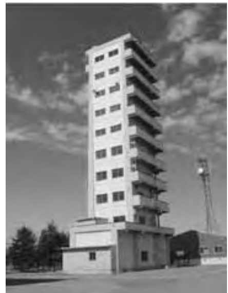
写真 1 消防訓練本塔外観
