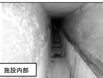
固定型訓練施設 2（全長約 7m 開口部 H70cm×W29cm 通路内最高高 70cm 最低高 70cm）
