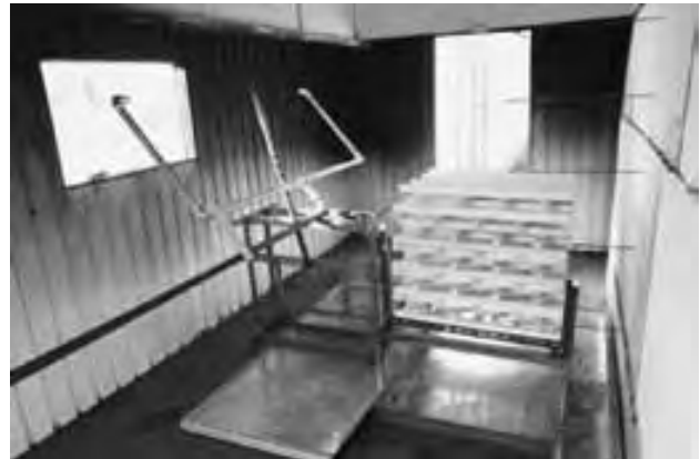
写真4 消火水放射前の二股配管設定状況
