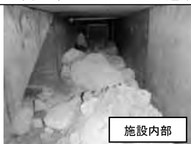
固定型訓練施設 1（全長約 17m 開口部 H55cm×W70cm 通路内最高高 80cm 最低高 35cm）
