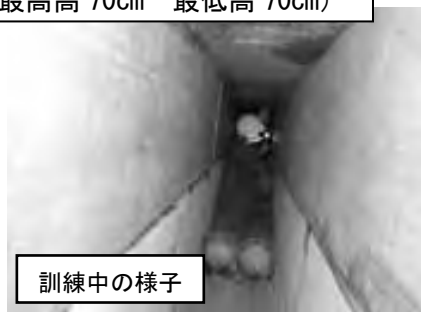
固定型訓練施設 2（全長約 7m 開口部 H70cm×W29cm 通路内最高高 70cm 最低高 70cm）
