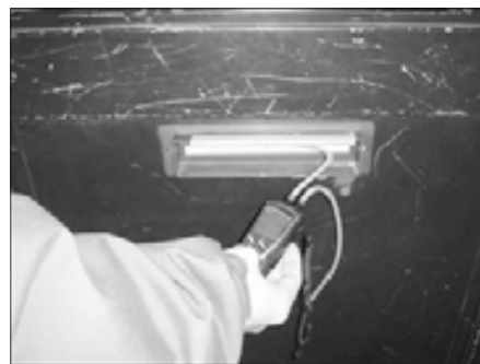
写真5 差圧の測定状況
