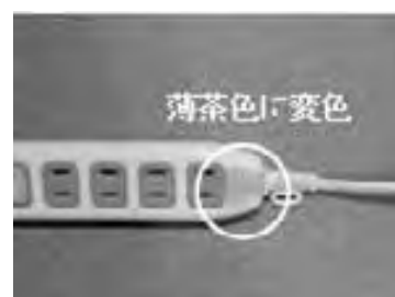
写真4 差込部の状況
