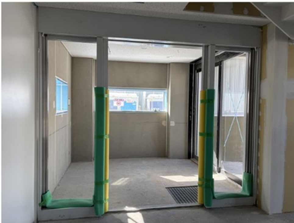
風除室の様子です。 新庁舎には、建物の室温環境を快適に保つため、風除室が設置されています。
