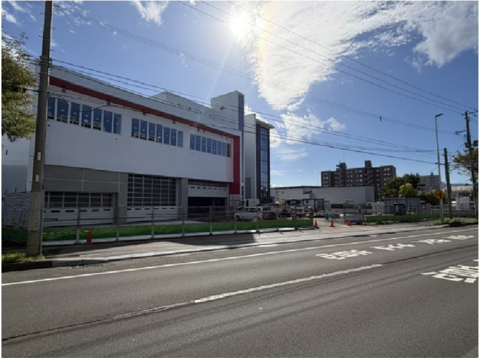
消防車や救急車が出入りしやすいように縁石の切り下げ工事も完了！
