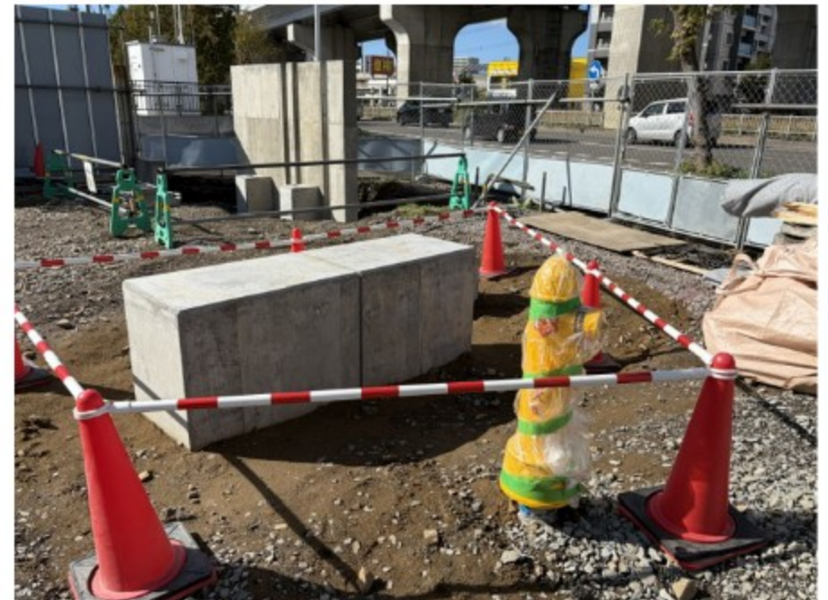
庁舎敷地内には、消火栓も完備
