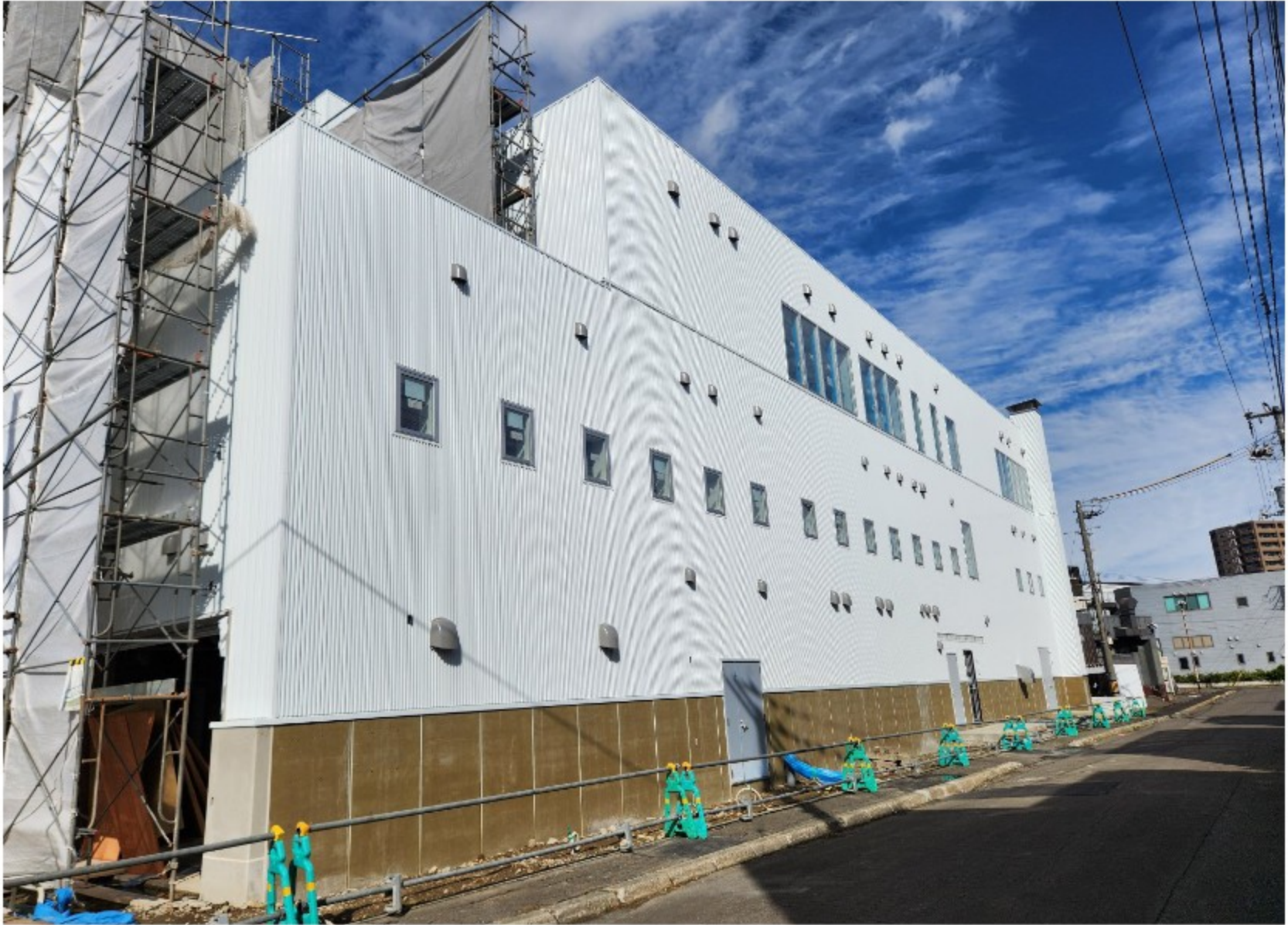
新庁舎の裏面も足場と仮囲いが撤去され、お披露目となりました。
