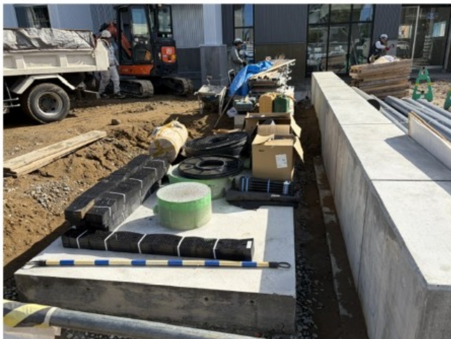
地下タンクもコンクリートが打設されてます。
