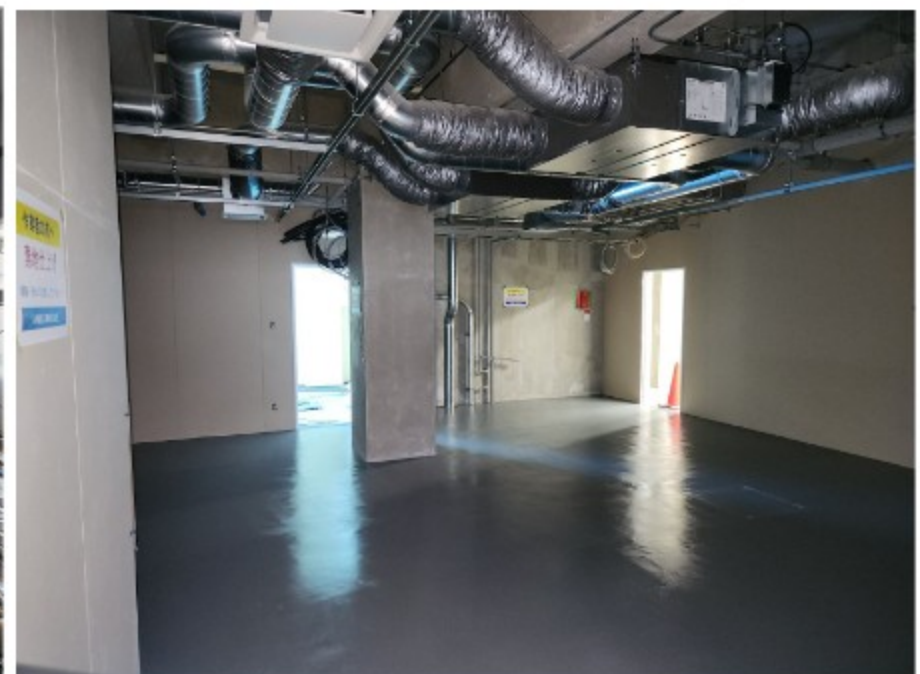
【資機材保管庫】
