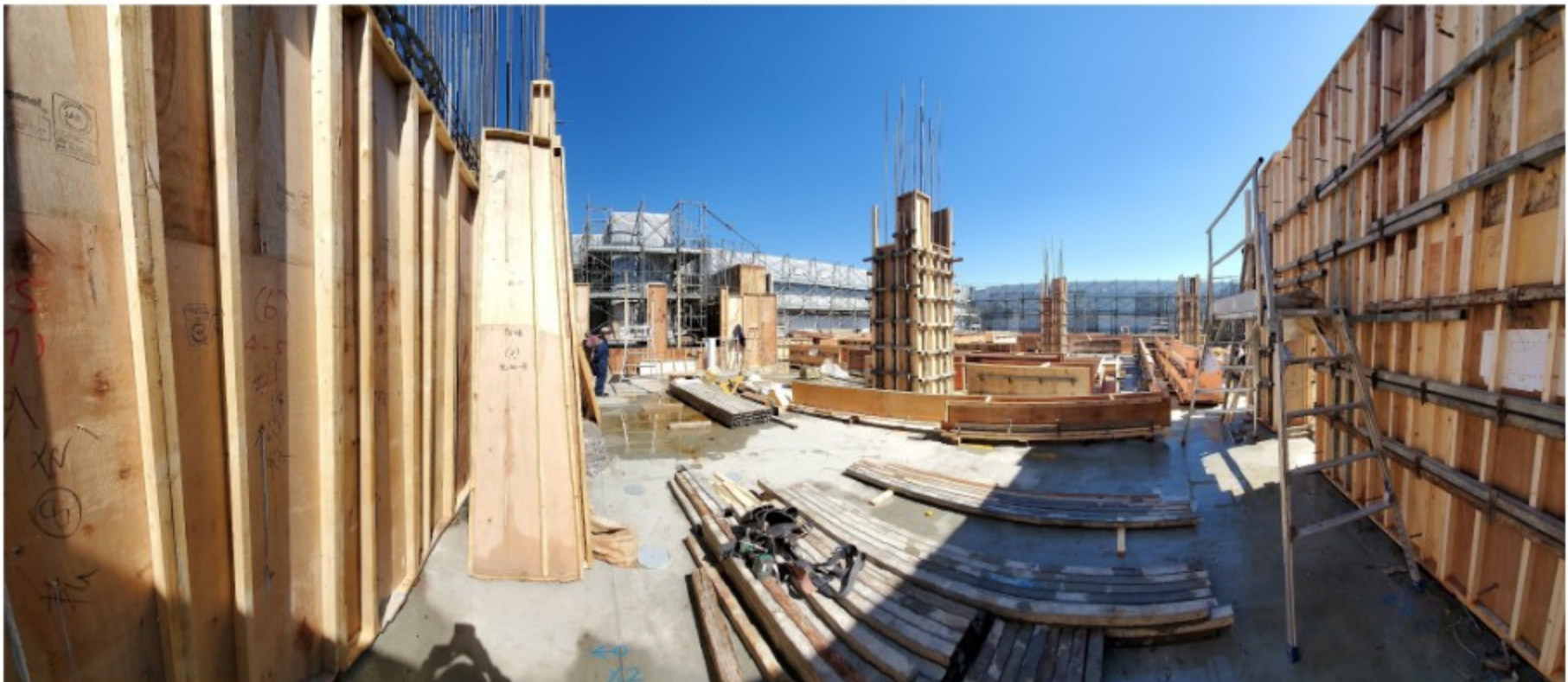
3階内壁の型枠と4階を支える柱の型枠工事の様子
