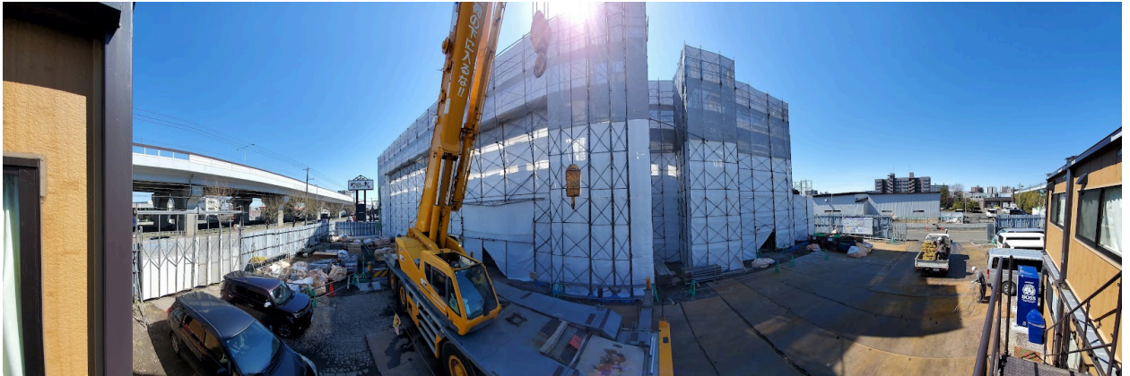
工事全景（パノラマモードで撮影）
