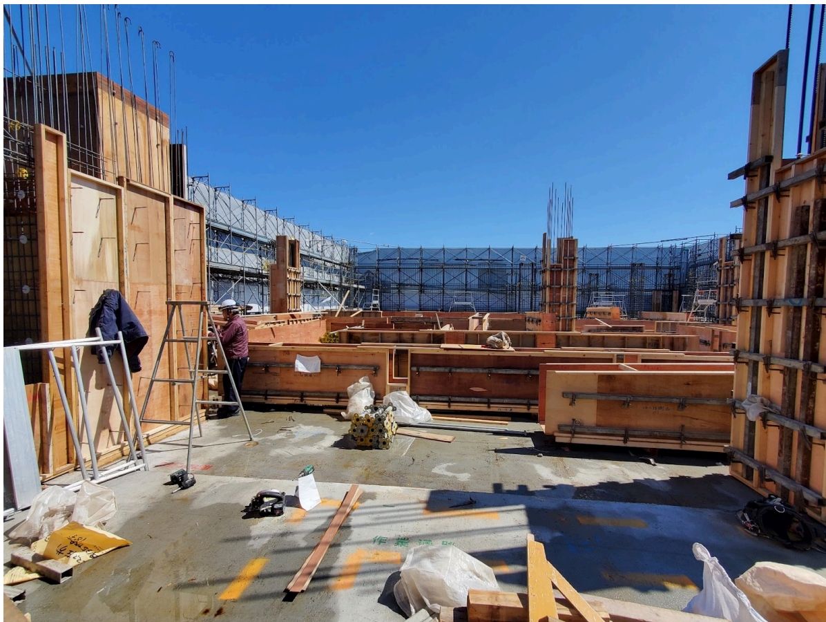
3階内壁の型枠と4階を支える柱の型枠工事の様子
