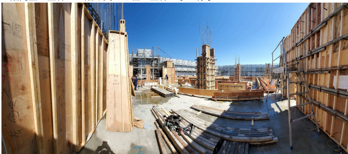
3階内壁の型枠と4階を支える柱の型枠工事の様子
