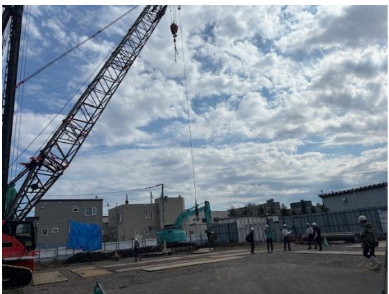
大きな重機で杭が打ち込まれていきます。
