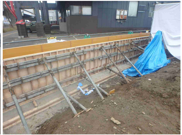
コンクリートを打設する準備万端です！
