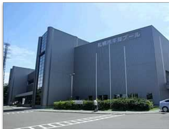
【水上会場】札幌市平岸プール
