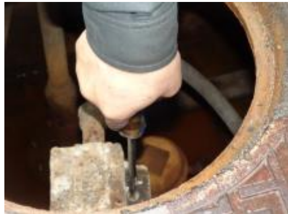
②テスト用プラグをマイナスドライバーで 外す。
