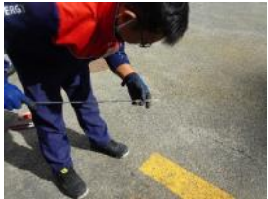
⑧触った感触等で漏えいの有無を確認する
