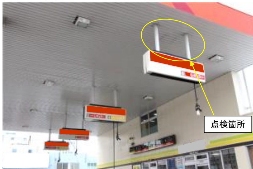
【懸垂式固定給油設備の例】
