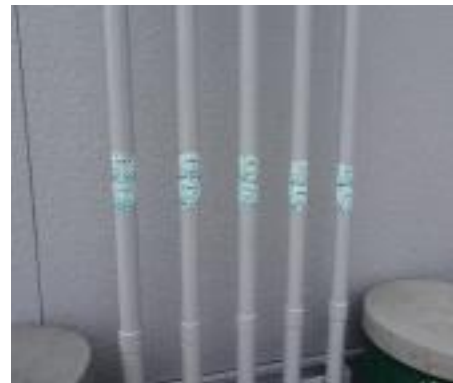
【漏れ点検のシール】
