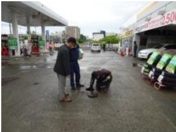
①地下タンクのマンホールを開ける。
