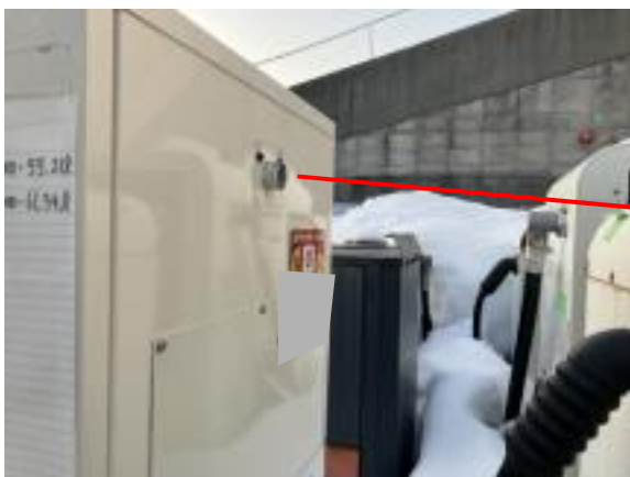
【カバーを外した通気口（通気管の先端）】
