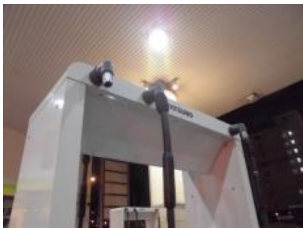
【ホースが根本から切断された計量機】
