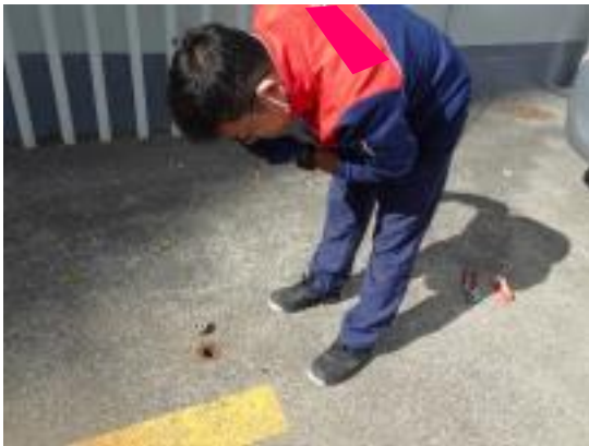
⑦臭いを嗅ぎ漏えいの有無を確認する
