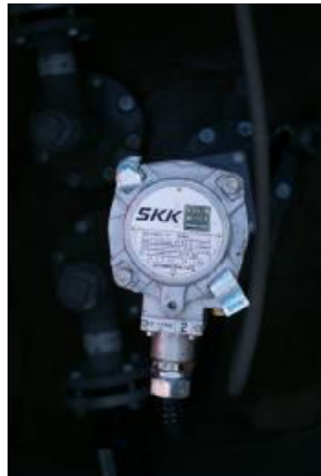
【液面計の例（地下タンクマンホール内）】
