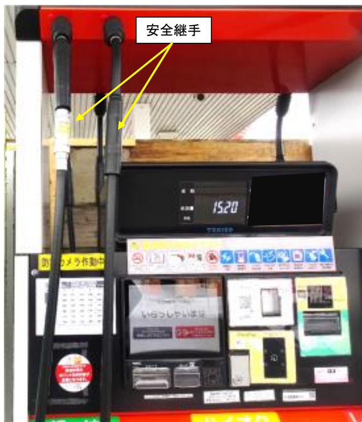
【ホースの安全継手の例】
