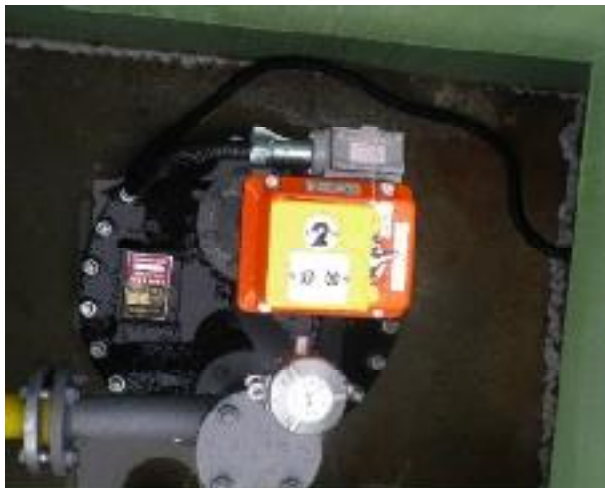
【液面計の例（地下タンクマンホール内）】
