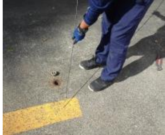
⑥検水棒等を抜き、色や濡れている部分を確認する
