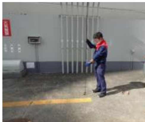
④検水棒等を挿入する
