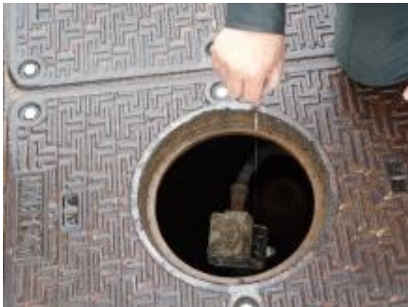
③外したプラグを持ち、テンションがかか るまでゆっくり引き上げる。
