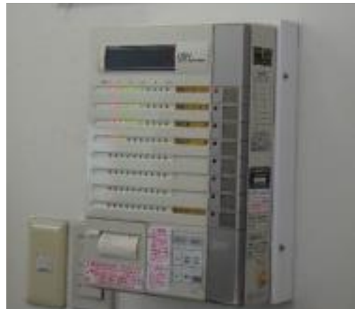
④液面計でテストしたタンクの異常ランプが点 灯し、警報が鳴るとともにレシートが出てくる。
