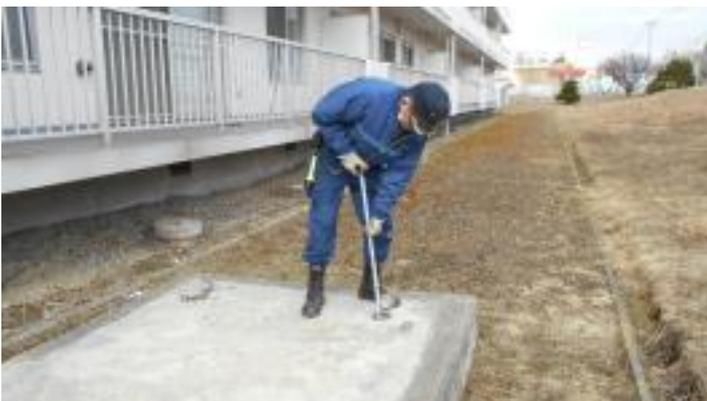
※ 写真は地下タンク貯蔵所の漏えい検査管にコンベックスを挿入し、深さを測っているところ
