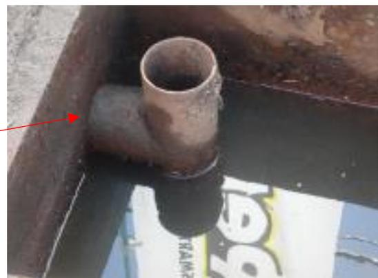
本来パイプの下から油の薄い水が次の槽へ流れ込むが、腐食によりパイプに穴が開くと、そこから油がパイプ内に入り込むため、油が分離されずに濃い油が次の槽へ流れ込むおそれがある。
