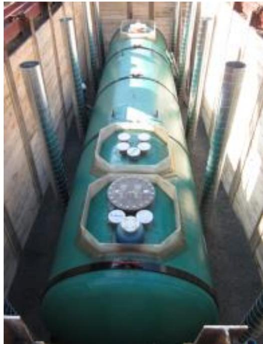
【鋼製一重殻タンク(アスファルト防水)の例】
