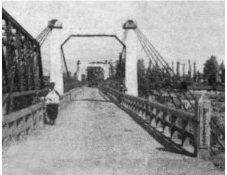
吊り橋時代の上白石橋。鉄道橋がすぐ隣にあるが、現在は50メートルほど離れている
