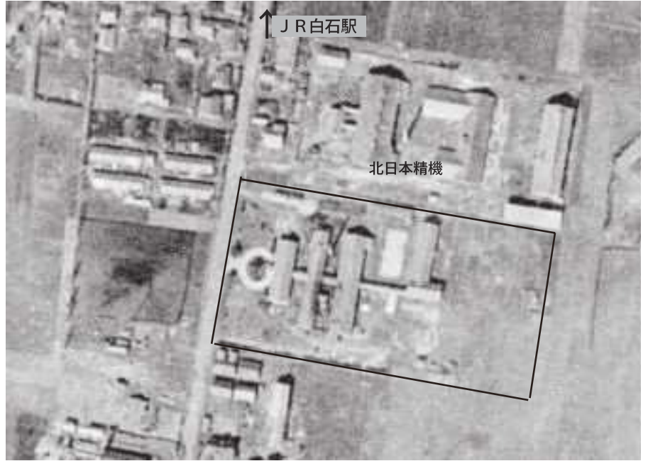
昭和22年頃の札幌石炭坑爆発予防試験所(米軍航空写真)
