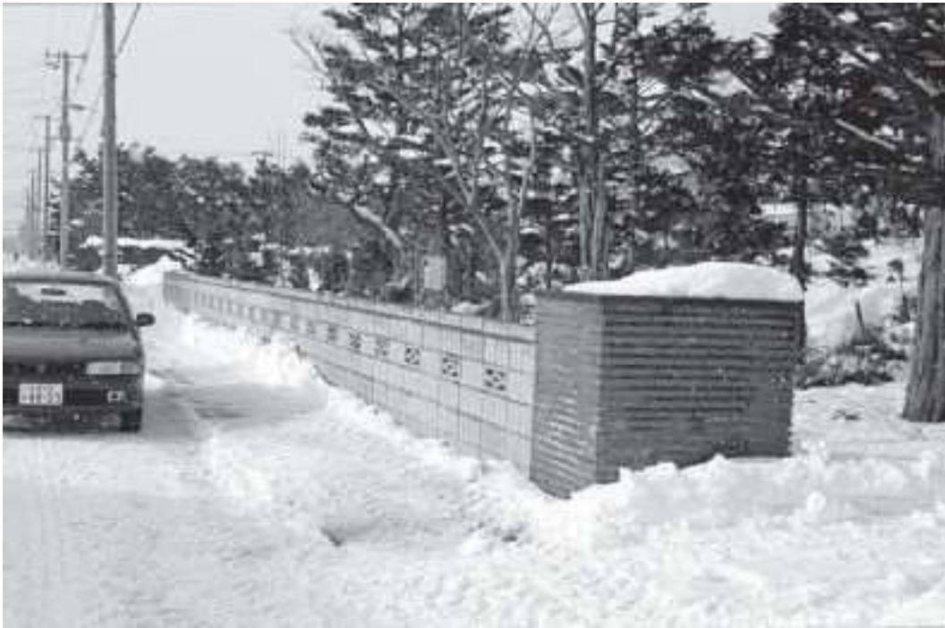
川下の中沢宅の塀の内側に標示板が設置されている
