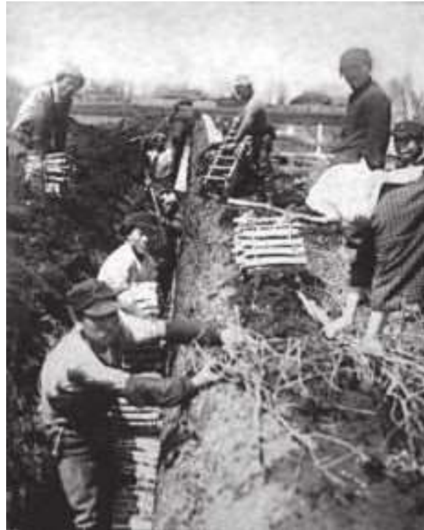
暗渠排水の作業風景
