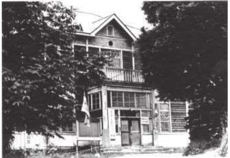
札幌市に編入した当時の白石村役場。建物は昭和4年に建てた
