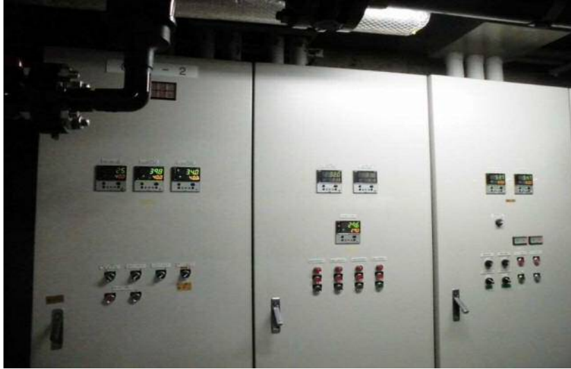
リラックスプラザ（デジタル指示温度調節器） 制御盤指示計
