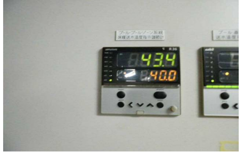
リラックスプラザ（デジタル指示温度調節器） プール床暖系統（5100）
