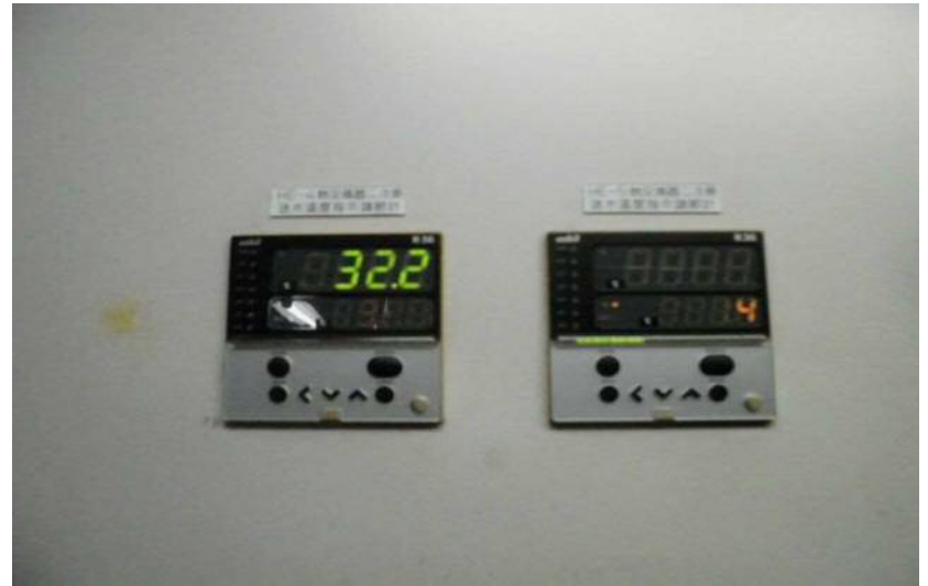
リラックスプラザ（デジタル指示温度調節器） 熱交二次側（2300）
