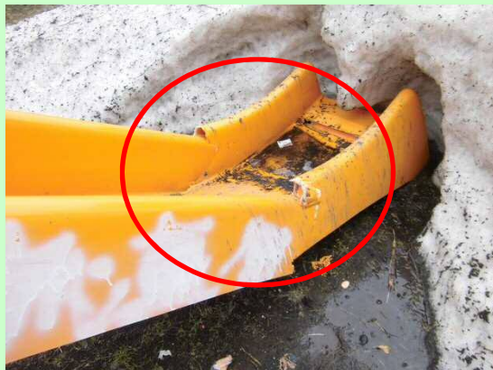
すべり台（滑走面の破損）
