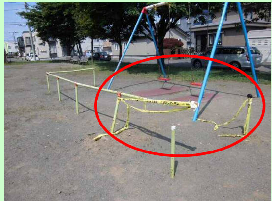
ブランコ安全柵（バーの破損、曲がり）
