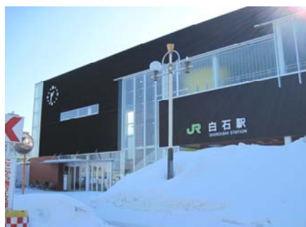
新しい駅舎（北側から撮影）
