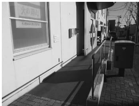
会館玄関スロープ
