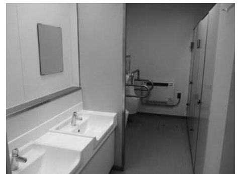
会館便器更新
