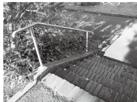
手摺(5力所設置)
