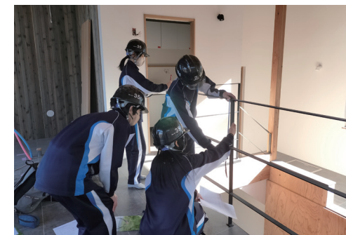
本物の工事現場で実際に現場監督の仕事を体験する中学生
