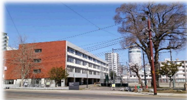
二条小学校（2017年3月完成） 小学校×まちづくりセンター×児童会館
