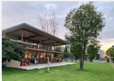
| 屋根や庇による半屋外空間
