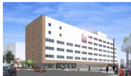
外壁に地元の白石煉瓦
