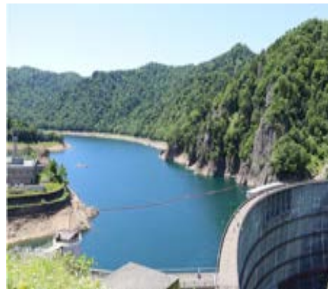
市民の水がめである豊平峡ダム
