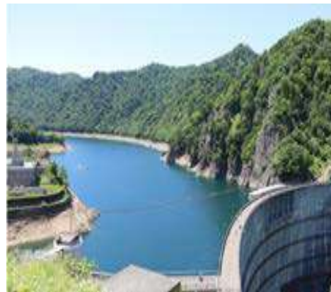
市民の水がめである豊平峡ダム
