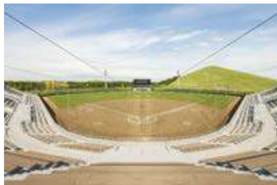
令和 7 年 4 月にリニューアルオープンした 「モエレ沼公園野球場」
