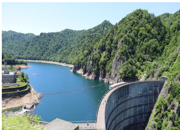
市民の水がめである豊平峡ダム
