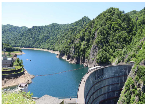
市民の水がめである豊平峡ダム
