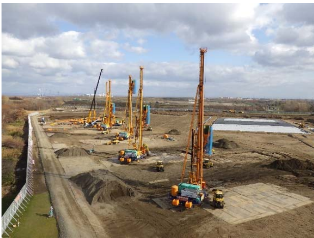
受入地全景（西側から東側を望む）
