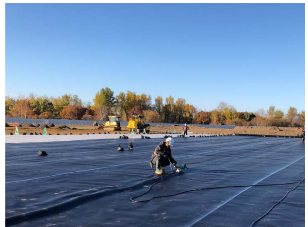
遮水シート施工状況
