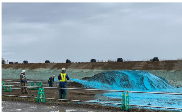
粉じん防止材散布状況
