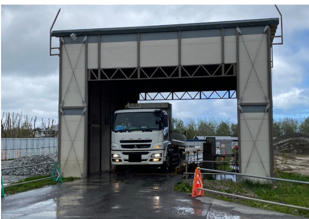
タイヤ洗浄状況
