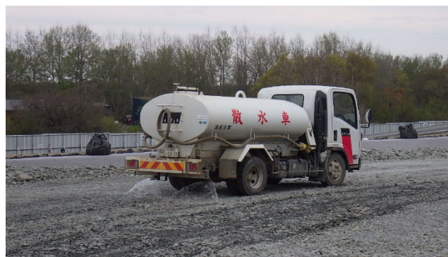
散水車による散水状況
