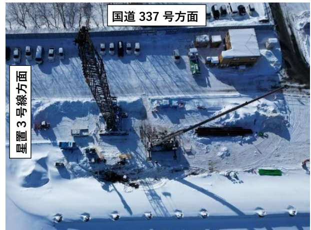
受入地南側 遮水壁施工状況（令和6年1月）
