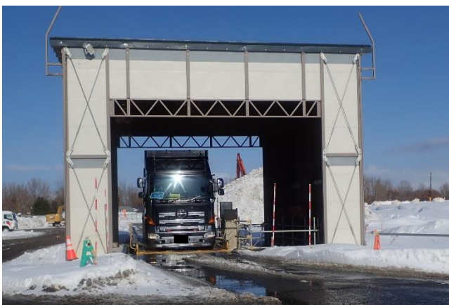
タイヤ洗浄状況
