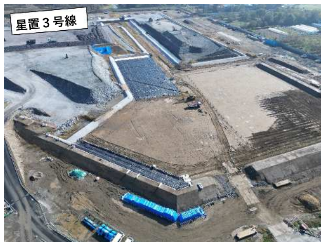
受入地南西側 造成状況（令和5年10月）
