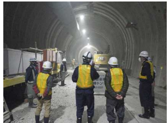
札幌トンネル富丘工区
