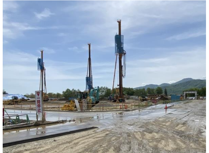
地盤改良（令和5年5月）
