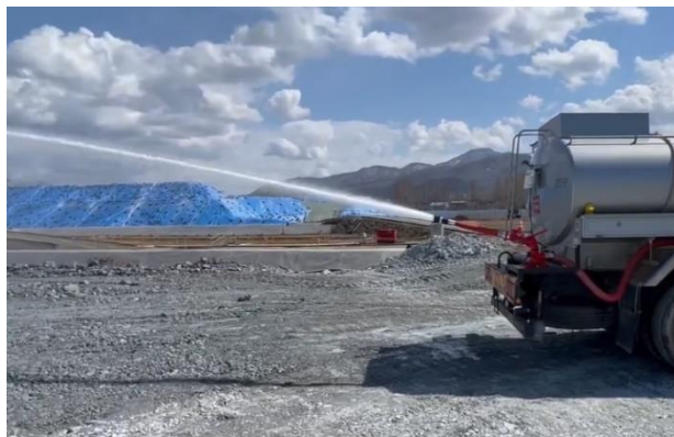
場内散水状況
