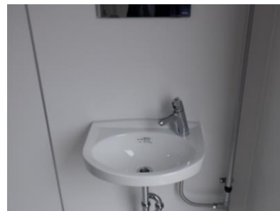
【手洗い場を設置しました】
