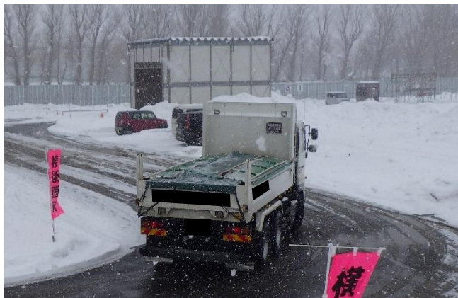
ダンプトラック荷台シート被覆状況
