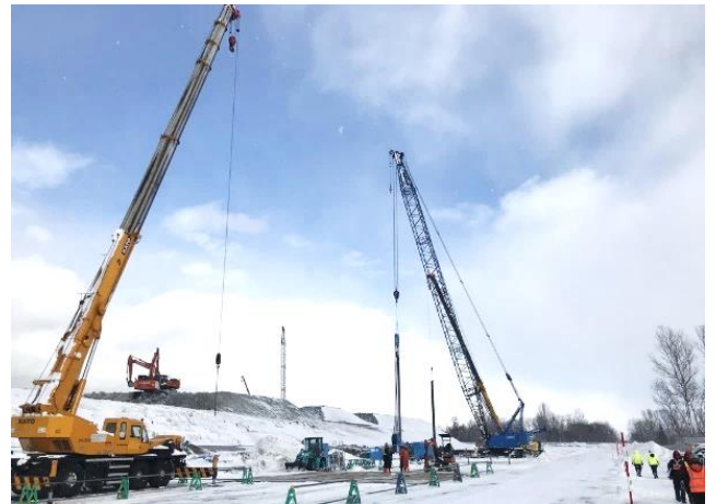
遮水壁施工状況（令和5年1月）
