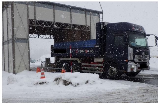
タイヤ洗浄状況
