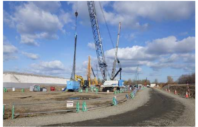
遮水壁施工状況（令和4年11月）
