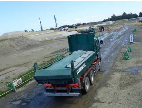
ダンプトラック荷台シート被覆状況
