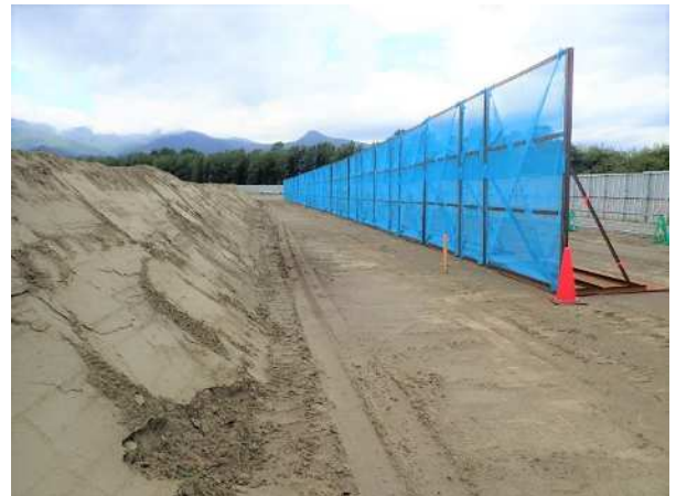
粉じん防止ネット設置状況
