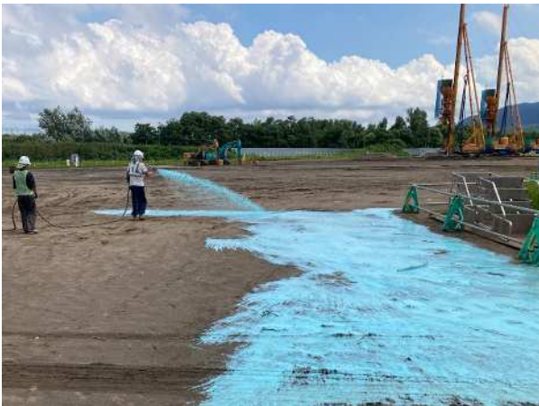
粉じん防止剤散布状況
