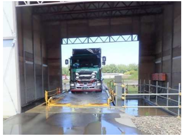
タイヤ洗浄状況
