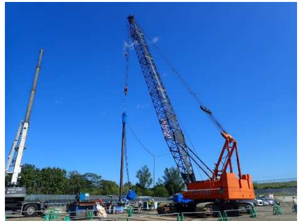
遮水壁施工状況（令和 4 年 9 月）
