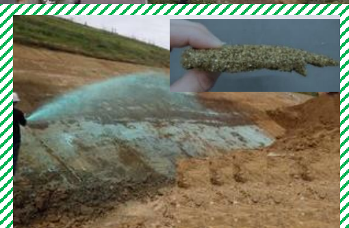
②粉じん防止剤の散布 被膜を形成する粉じん防止剤を散布。主成分はチューインガムなどにも使用され、人体に無害。長期的には微生物により分解される。なお、施工範囲がわかるよう、緑色の着色料（食用）にて着色【稼働中の盛土範囲を除くほぼ全域】
