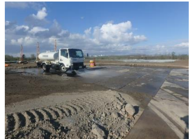
場内散水状況
