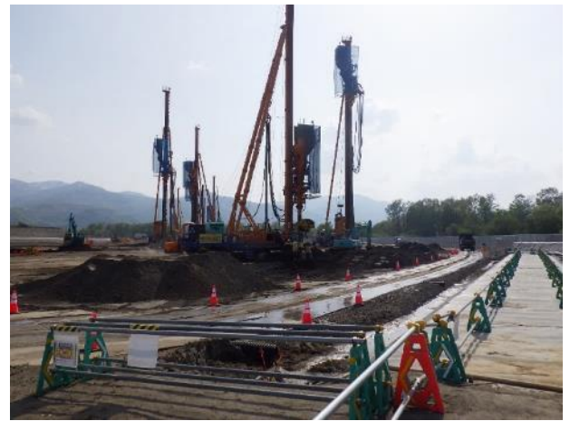
地盤改良施工状況（令和4年5月）
