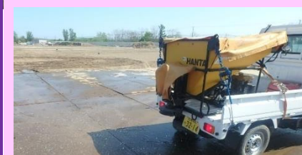
④塩化カルシウムの散布 作業員が近づけない場所へ始業前に散布し、湿潤状態を維持【重機直下等】
