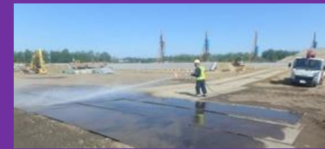
③ハイウォッシャー・放水銃付き散水車による散水 作業員が局部的に散水し、粉じんを抑制【稼働中の盛土周辺、走行路】
