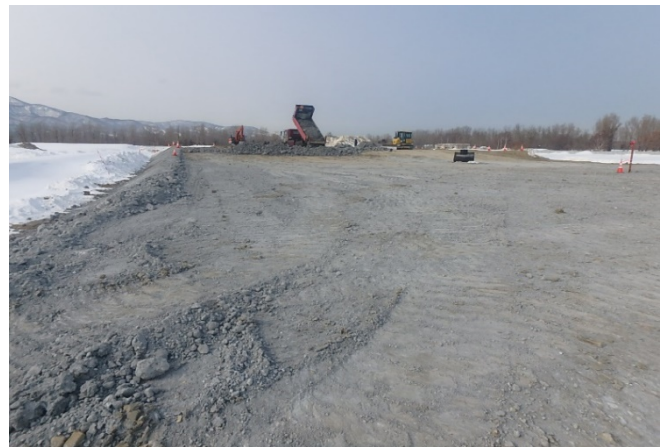
トンネル掘削土受入れ状況（令和4年2月）
