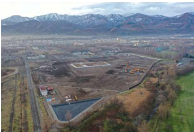
受入地全景（北側から南側を望む）（令和3年12月）
