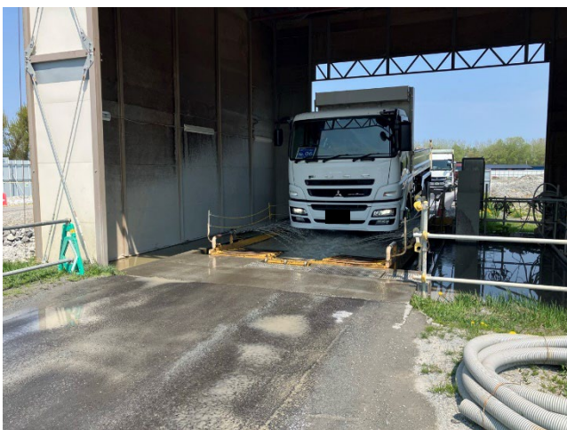
タイヤ洗浄状況
