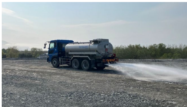
散水車による散水状況
