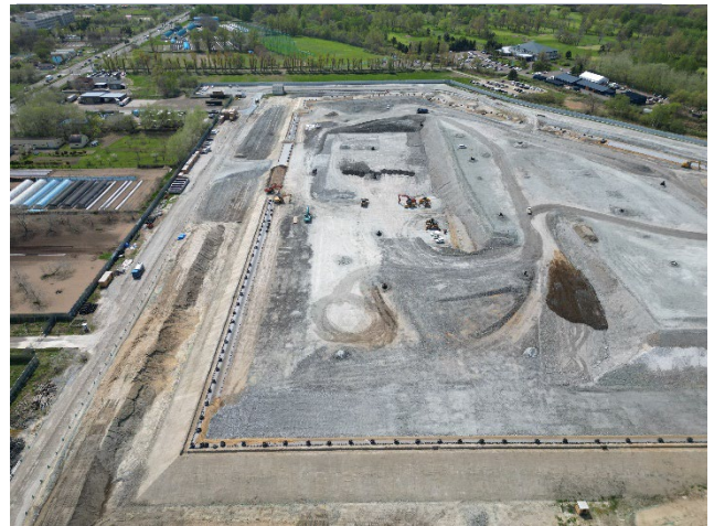
盛土状況（東側から西側を望む）（令和7年5月）
