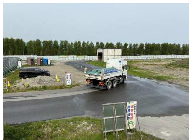
荷台のシート状況
