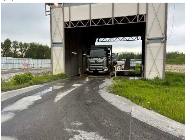
タイヤ洗浄状況
