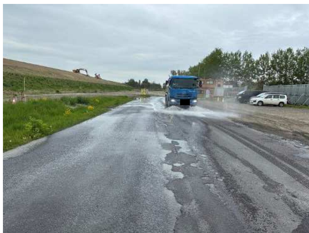
散水車による散水状況
