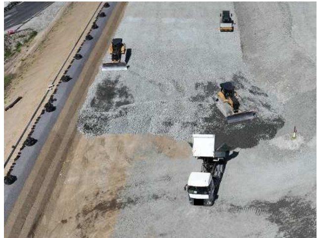
盛土状況(令和 8 年 5 月)
