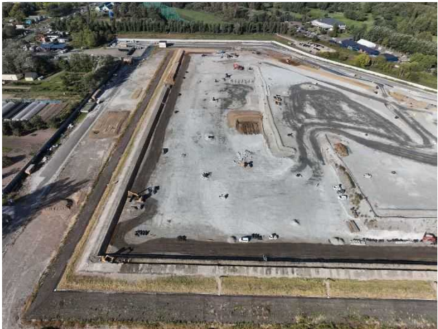
対策土盛土状況（令和 7 年 10 月）
