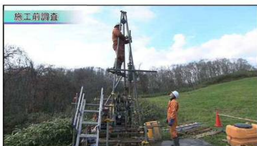
○ボーリング調査
