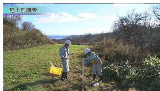
○地下水観測孔設置
