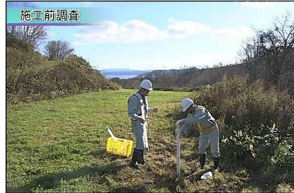
・地下水の水質、深さを調査
