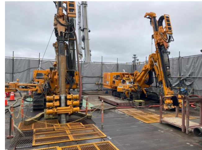
凍結管埋設の様子
