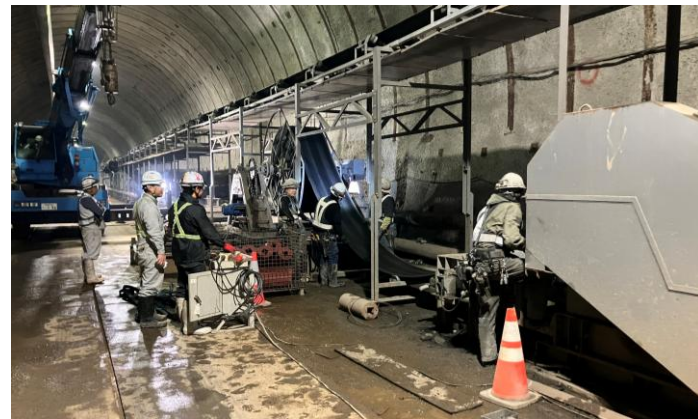
天狗工区の迎え掘り準備状況(本坑・斜坑の交点付近のベルトコンベア撤去状況)
