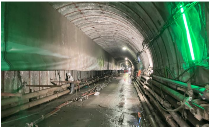
天狗工区の迎え掘り準備状況(本坑・斜坑の交点付近のベルトコンベア撤去状況)
