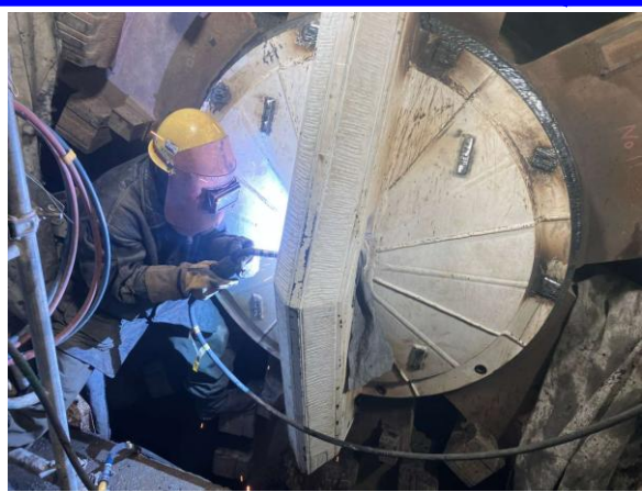
フィッシュテール取付状況
