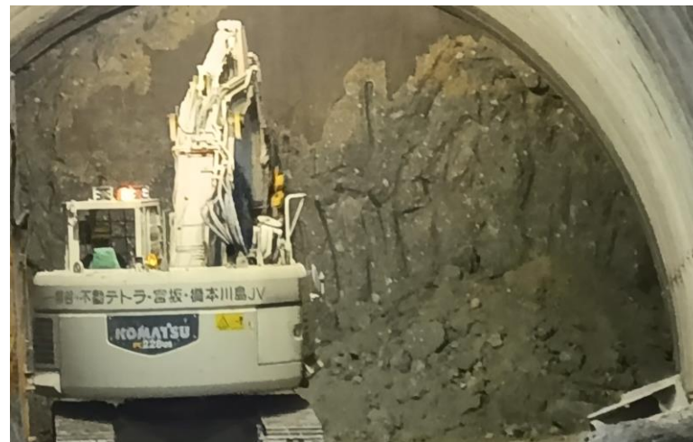
NATM掘削状況
