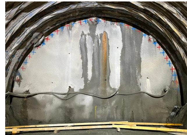
札幌トンネル(石倉) 多量湧水処理状況
