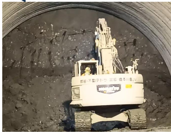
NATM掘削状況
