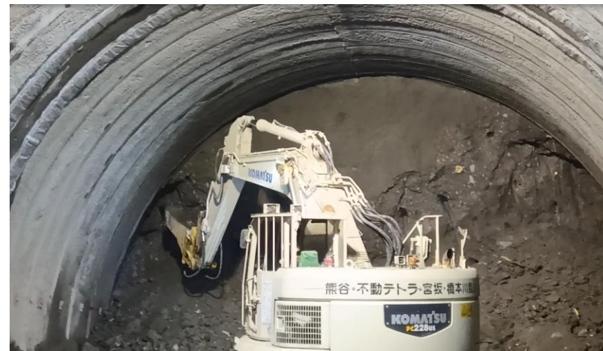
NATM掘削状況
