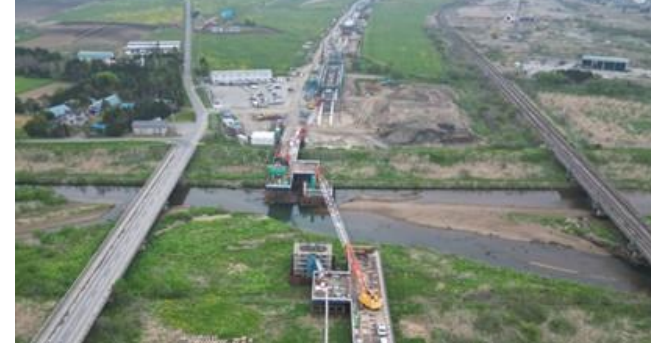
写真⑪ 栄原高架橋(長万部町)
