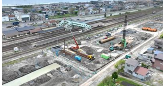
写真⑬ 長万部駅高架橋(長万部町)
