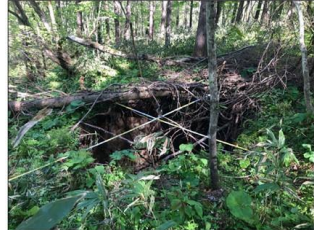
地表面陥没状況
