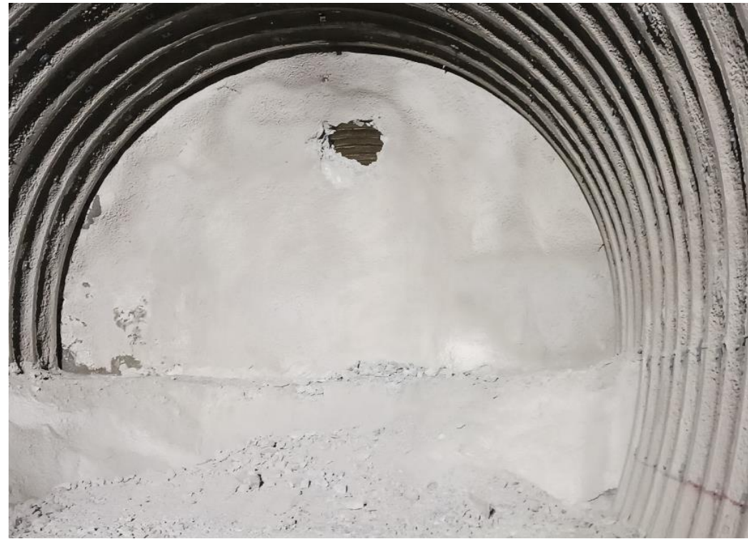
掘削完了地点の状況
