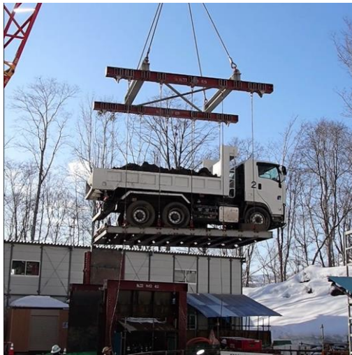
発生土搬出状況(到達立坑部(地上部))
