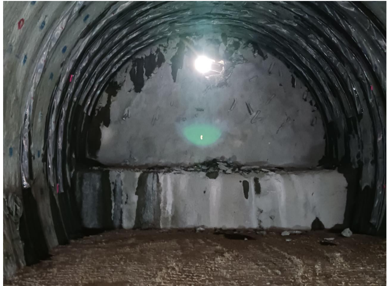
掘削完了地点の状況
