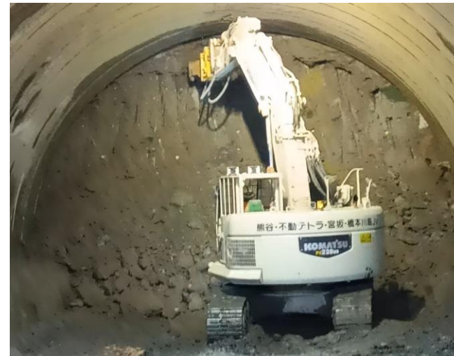
NATM掘削状況
