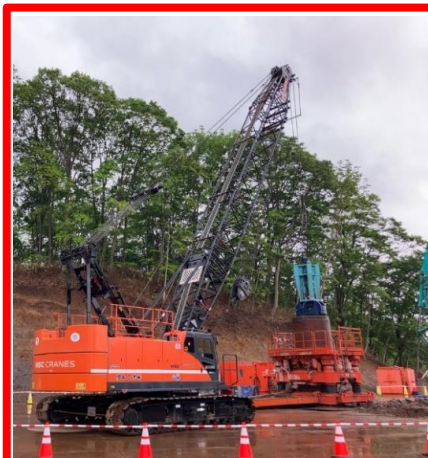
岩塊撤去状況
