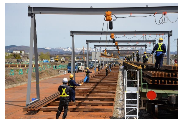
150mレールの貨車からの取り出し
