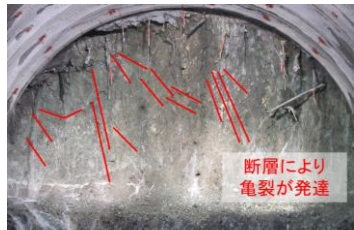
【特徴1】断層運動に伴う弱部の形成
