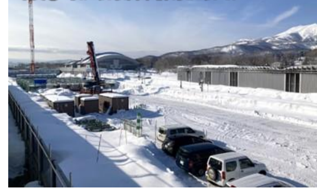
写真⑥ 倶知安駅高架橋(倶知安町)
