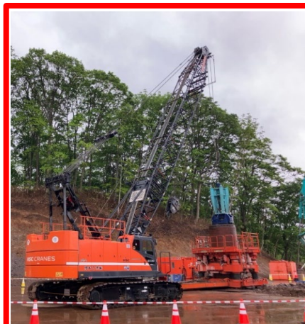
岩塊撤去状況
