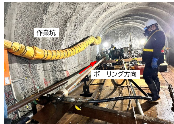
南鶉工区ボーリング削孔状況
