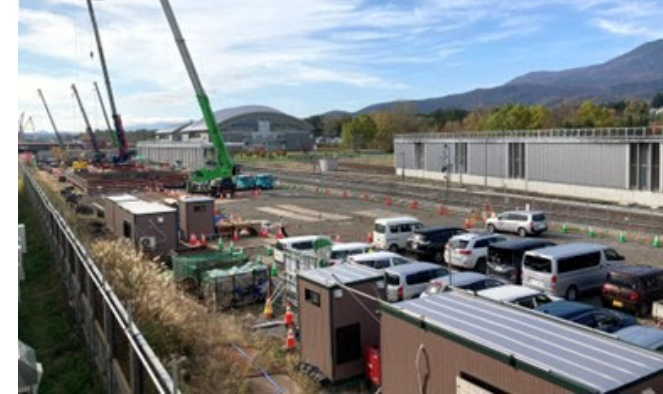
写真⑥ 倶知安駅高架橋(倶知安町)
