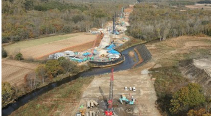
写真⑤ 琴平高架橋(倶知安町)
