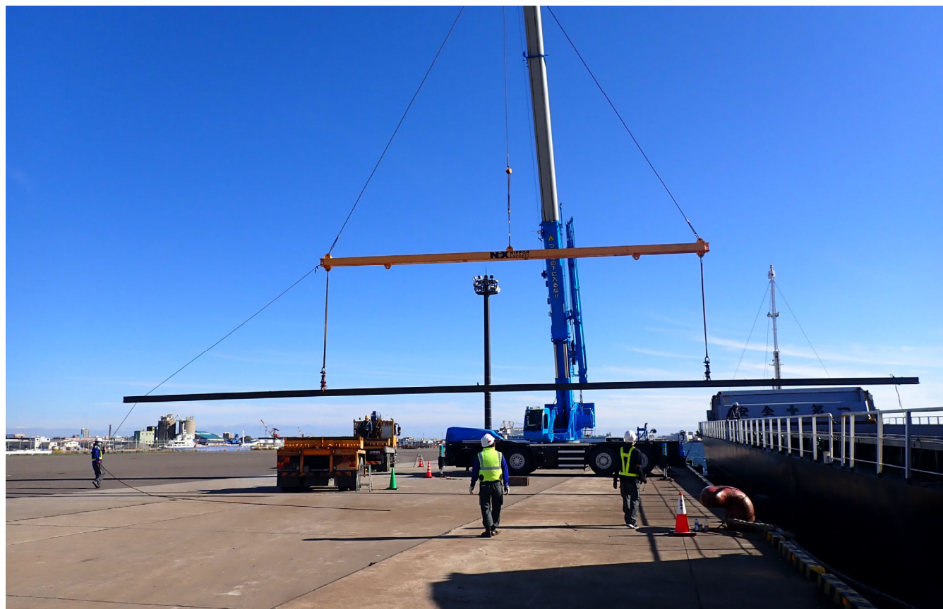
レール陸揚げ状況
