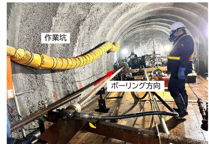
南鶉工区ボーリング削孔状況
