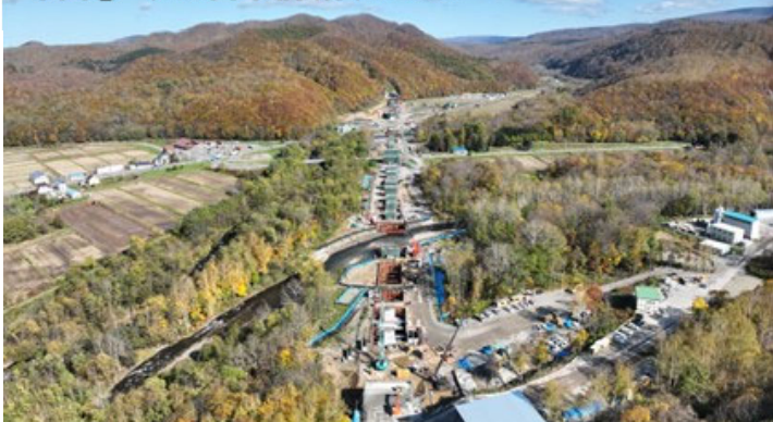
写真④ 明治高架橋(赤井川村)
