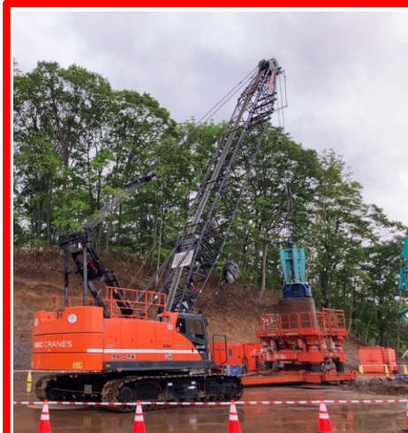
岩塊撤去状況
